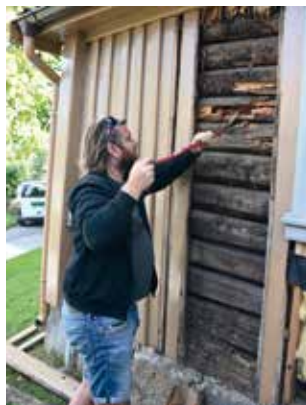
Åpning av vegg Gamlestua avdekket skjult råte i tømmeret. Pål Martinsen anleggsleder fra Tune Byggservice AS.
